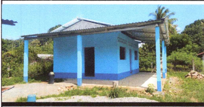
Foto1: sustitucion de lamina, por lamina troquelada alizinc calibre 26 de 12 pies.
