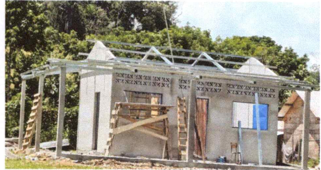
Foto 4: sustitucion de soporte de madera por metal
